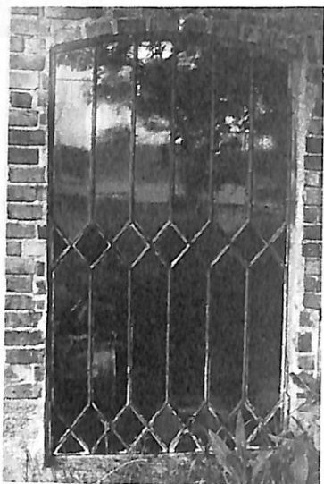
Et af de gamle vinduer findes endnu intakt i baghuset på Kvolsvej 2.
